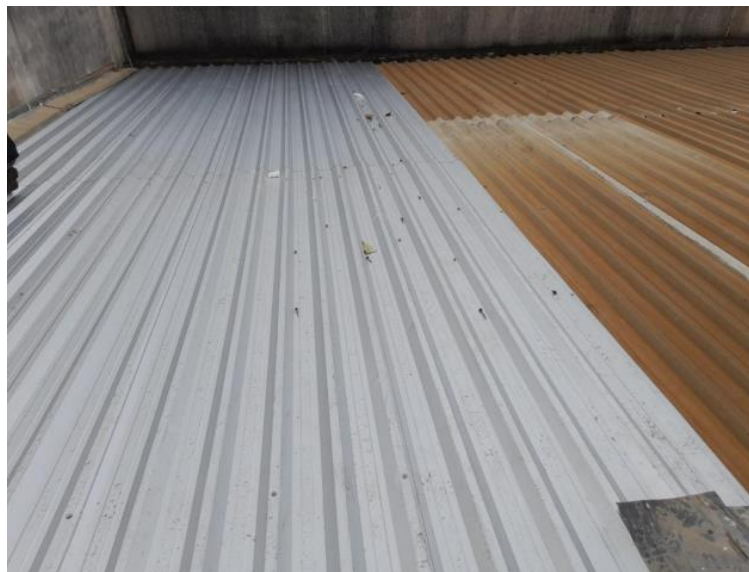
Imagem 03 – Substituição de telhas metálicas termoacústicas
